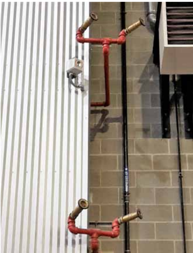
A TŰZTÉR SZÉLÉN AZ ÉPÜLET SZERKEZETÉNEK VÉDELMÉT SZOLGÁLÓ HŐSZIGETELT ACÉLBORÍTÁS ÉS AZ OLTÁSHOZ HASZNÁLT HABÁGYÚK
