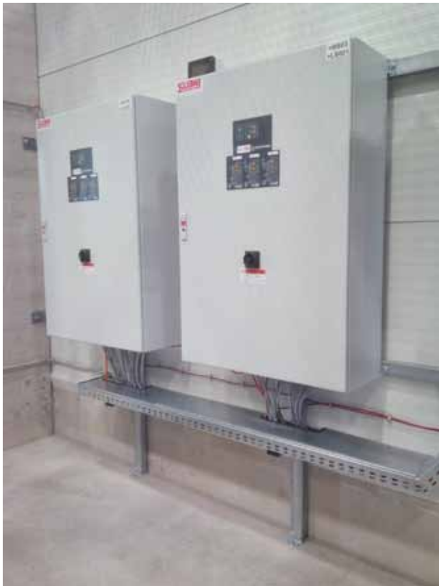
ÁRUKIHORDÓ RENDSZER ÉS SZÜNETMENTES TÁP
