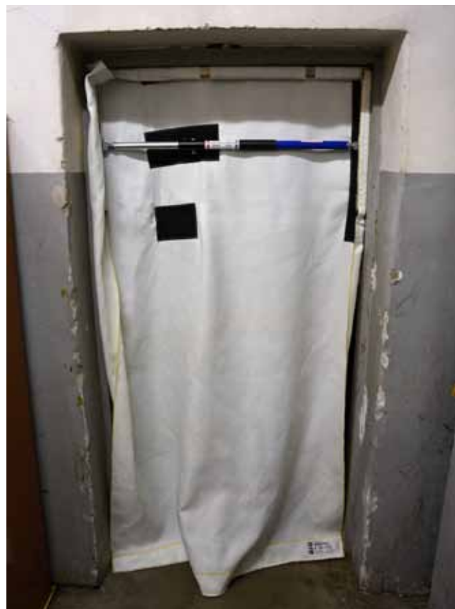
AJTÓNYÍLÁS A FÜSTGÁTLÓ FÜGGÖNY TELEPÍTÉSE UTÁN
