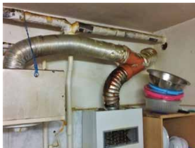
SZABÁLYTALANUL BEKÖTÖTT PÁRALESZÍVÓ
