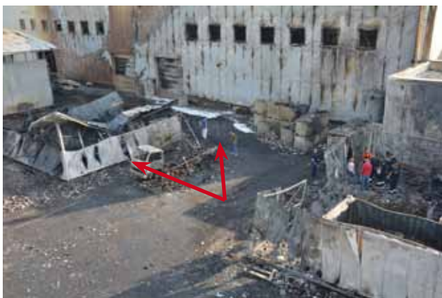
A TŰZ TERJEDÉSE A HULLADÉKSZIGETRŐL A KISTEHERAUTÓRA ÉS A GYÁRTÓCSARNOK KEVERŐRÉSZE MELLETTI IBC-TARTÁLYOKRA
