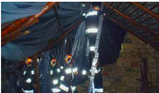
VIHAR ÁLTAL MEGBONTOTT TETŐ IDEIGLENES FEDÉSE
