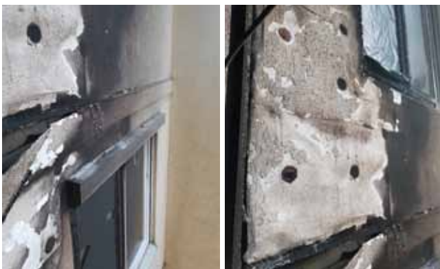
A VAKOLT HOMLOKZATI HŐSZIGETELŐ RENDSZER TŰZ-ESETI VISELKEDÉSE A BELSŐ UDVARBÓL NYÍLÓ LÉPCSŐ-HÁZ MELLETTI HOMLOKZATFELÜLETEN
