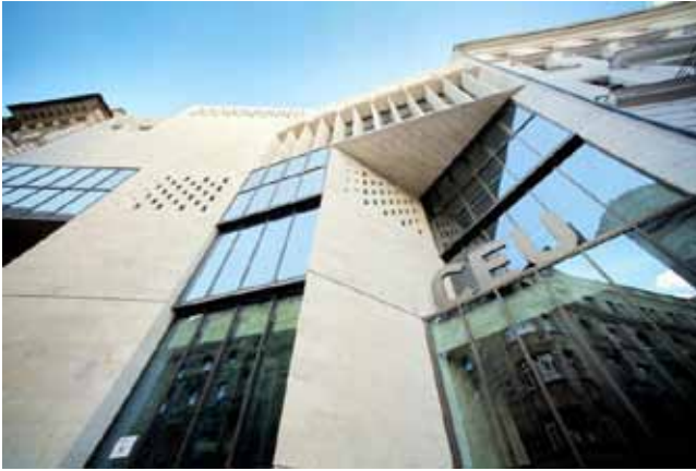
2. ÁBRA: ÁTSZELLŐZTETETT LÉGRÉS NÉLKÜLI, VASTAG KŐBURKOLATTAL ELLÁTOTT HOMLOKZAT PÉLDÁJA, AMELYNÉL A HOMLOKZATBURKOLAT TARTÓSZERKEZETÉT TŰZHATÁSTÓL VÉDETTE ALAKÍJTJÁK KI
