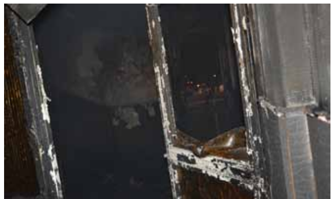
A FOLYOSÓ ÉS A LÉPCSŐHÁZ KÖZÖTTI ACÉLSZERKEZETŰ, DRÓTŰVEG BETÉTES AJTÓK EGYIKÉNEK KÁROSODÁSA
