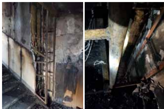
A MARKUSOVSZKY TÉR ÉS KÖZTELEK UTCAI SAROK FELŐLI LÉPCSŐHÁZ MELLETTI AKNA SZERKEZETE ÉS KÁROSODÁSAI
