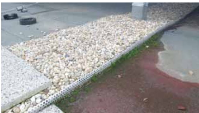
9. ÁBRA: A VÍZELVEZETÉS ÚTJÁBAN LÉTESÍTETT TETŐSZINTI TŰZTERJEDÉS ELLENI GÁT ÁLTAL FELTORLASZTOTT CSAPADÉKVÍZ HATÁSA: VÖRÖSALGA MEGJELENÉSE ÉS MOHÁSODÁS (A SZERZŐ FOTÓJA)
