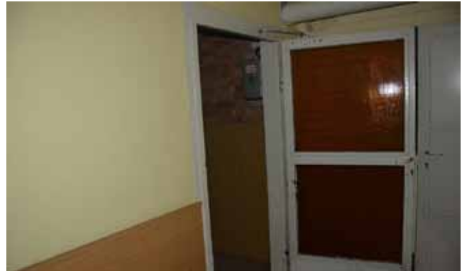
A FOLYOSÓ ÉS A LÉPCSŐHÁZ KÖZÖTTI ACÉLSZERKEZETŰ, DRÓTŰVEG BETÉTES AJTÓK EGYIKE (FORRÁS: FKI)
