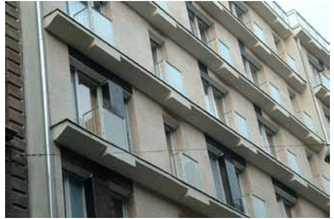
6. ÁBRA: HOMLOKZATI TŰZTERJEDÉS ELLENI VÉDELEM MEGOLDÁSA ELŐREGYÁRTOTT, KÖNNYŰBETON MAGHŐSZIGETELÉSŰ, VASBETON KÉRGEZÉSŰ TŰZTERJEDÉS ELLENI GÁTAKKAL (A SZERZŐ FELVÉTELE)
