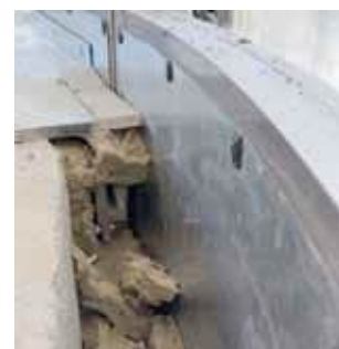
TŰZTERELŐ LEMESES MEGOLDÁS KIALAKÍTÁSA A GYAKORLATBAN
