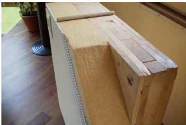
FA ÉS FAGYAPOT FALSZERKEZET
