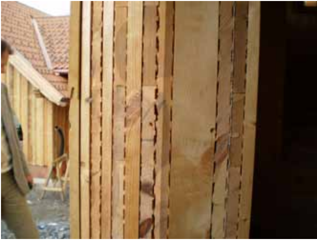
FAHÁZ FALSZERKEZETE
