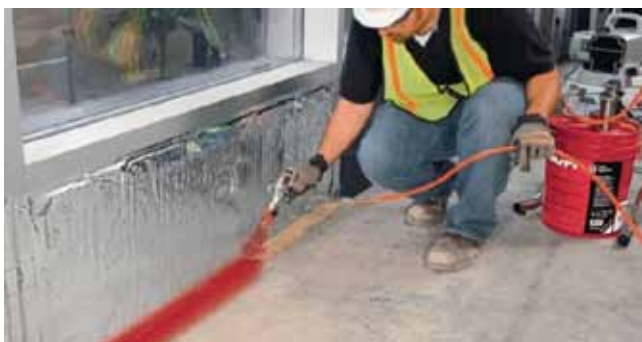
FÜGGÖNYFAL GYORS ÉS HATÉKONY LEZÁRÁSA A HILTI CFS-SP WB TERMÉKÉVEL
