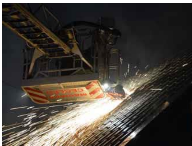
LEMEZFEDÉS – FÜSTELVEZETŐ NYÍLÁS VÁGÁSA
