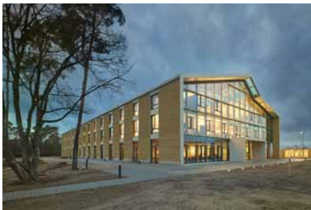
DÖNGÖLT FÖLDFALAK ÉS TELJESEN ÜVEGEZETT HOMLOKZATOK
