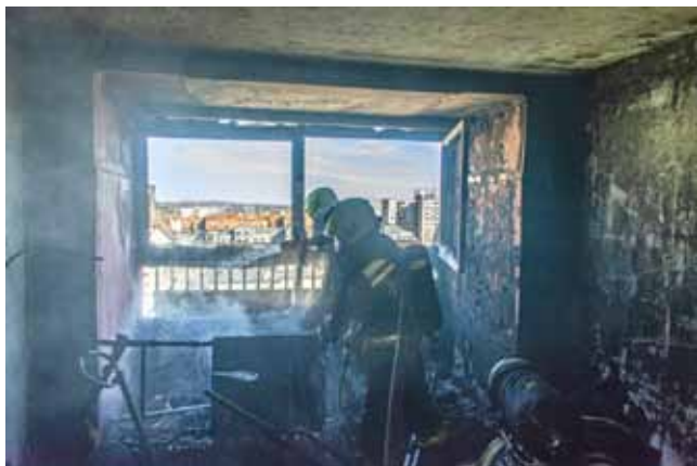
MAGAS HŐHATÁS – A BETONIG KÁROSODOTT FALAK
