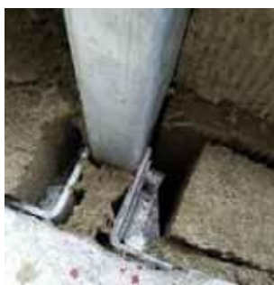
TŰZTERELŐ LEMESES MEGOLDÁS KIALAKÍTÁSA A GYAKORLATBAN
