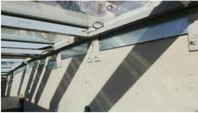
LEMEZFEDÉSI NEHÉZSÉGEK A TŰZTERELŐ LEMEZES KIALAKÍTÁSÁNÁL
