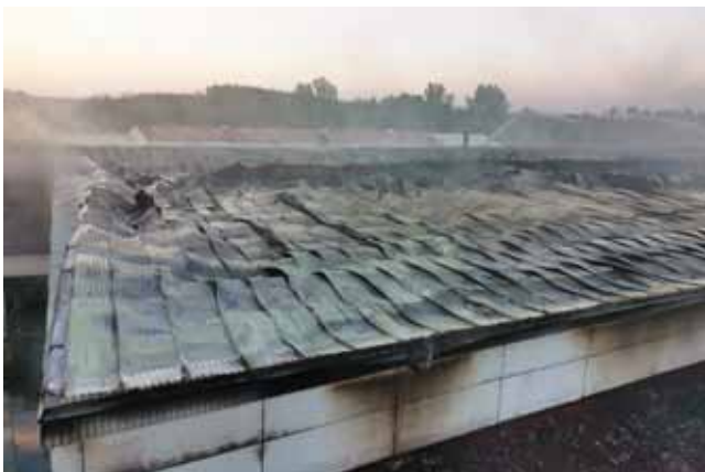
A BEDŐLT TRAPÉZLEMEZ HÉJAZAT A DÉLI OLDALON
