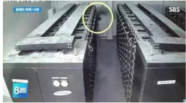
A HŐMEGFUTÁS PILLANATA BIZTONSÁGI KAMERÁN, EGY AKKUMULÁTORSZEKRÉNY ESETÉN
