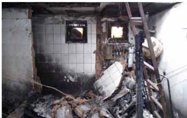
A FÜRDŐSZOBA (B) ÉS A KAZÁNHÁZ A PADLÁSFELJÁRÓVAL (J). A KÖZTÜK LÉVŐ FAL A KAZÁNHÁZ FELÉ KIDŐLVE
