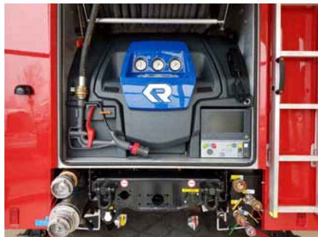
JÓL ÁTTEKINTHETŐ SZIVATTYÚTÉR
