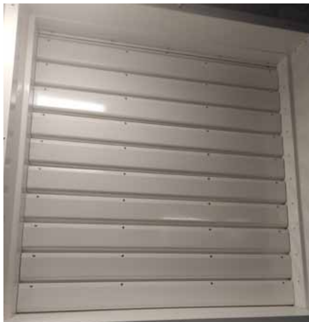
NYOMÁSLEVEZETŐ A TŰZGÁTLÓ SZERKEZETBEN
