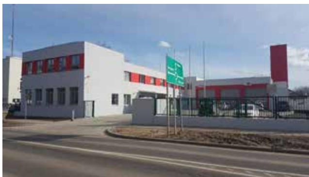
AZ ÚJ FEHÉRGYARMATI LAKTANYA LÁTVÁNYTERVEN (FENT) ÉS A VALÓSÁGBAN (LENT), HANGSÚLYOS TÖMLŐSZÁRÍTÓ TORONNYAL (TERVEZŐ: TOTAL-BAU KFT.)
