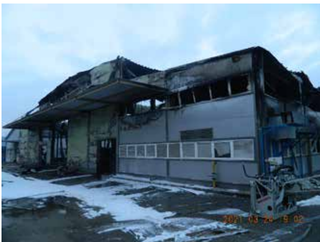
A CSARNOK KEVÉSBÉ KÁROSODOTT RÉSZE
