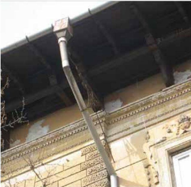
3. ÁBRA - FÜGGŐERESZ CSATORNA DÍSZES EJTŐVEZETÉK-TARTÓ KONZOLLAL, FAANYAGÚ ERESZ-KÉPZÉSSSEL (FOTÓ: LACZKOVICS JÁNOS)
