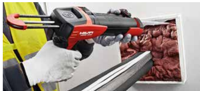
INJEKTÁLÁS HILTI KINYOMÓPISZTOLLYAL
