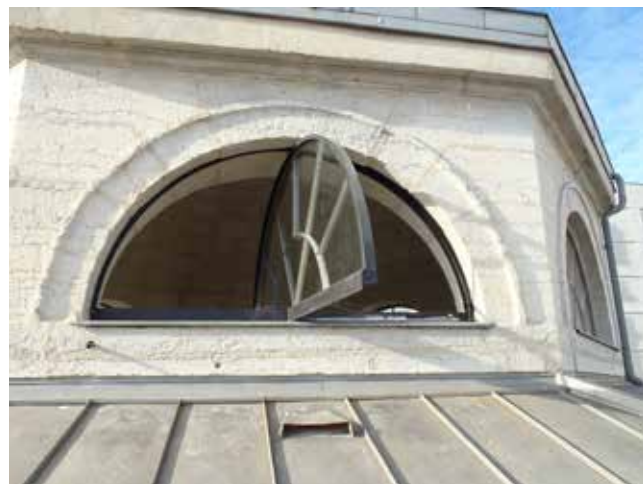
MŰEMLÉKHEZ: EXUBAIE MH HOMLOKZATI HŐ- ÉS FÜSTELVEZETŐ (ABLAK) SZERKEZET
