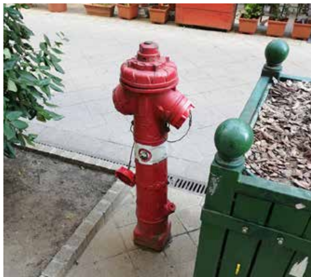
TŰZCSAP KIFOLYÓCSONKJÁT AKADÁLYOZÓ, FÁVAL BEÜLTETETT UTCABÚTOR
