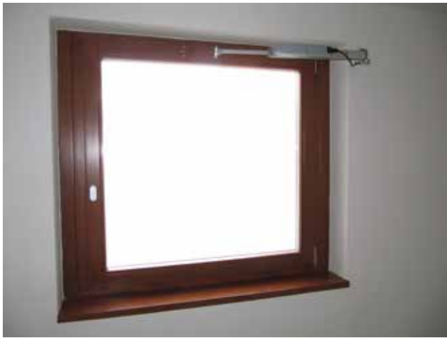
HELYBEN SZERELT ABLAK + MOTOR – KISZAKADT A MOTOR NYAKA A NYÍLÓSZÁRNYRÓL
