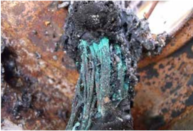
A KLÓR KICSAPÓDÁSA A VÖRÖSRÉZ KÁBELEN
