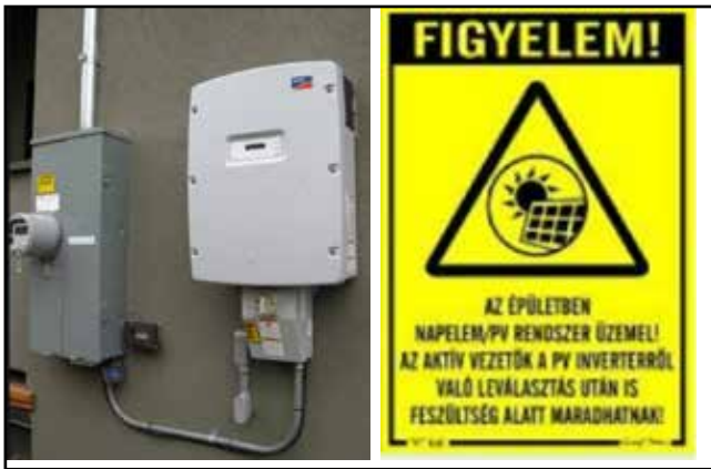
NAPELEM INVERTER ÉS LEVÁLASZTÁSRA FIGYELMEZTETŐ TÁBLA
