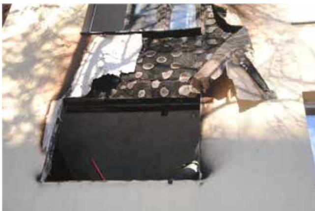
A TŰZ ÁLTAL ÉRINTETT ÉPÜLET KÜLSŐ FALSÍKJA
