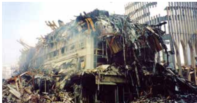
AZ ELPUSZTÍTOTT ÉPÜLET
