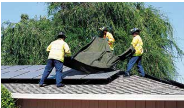
NAPELEMMODULOK LETAKARÁSA
