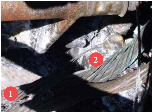
A KIÉGETT GENERÁTOR (FENT) ÉS A CSATLAKOZÓ VEZETÉKEK (LENT) 1: testkábel, 2: töltőkábel
