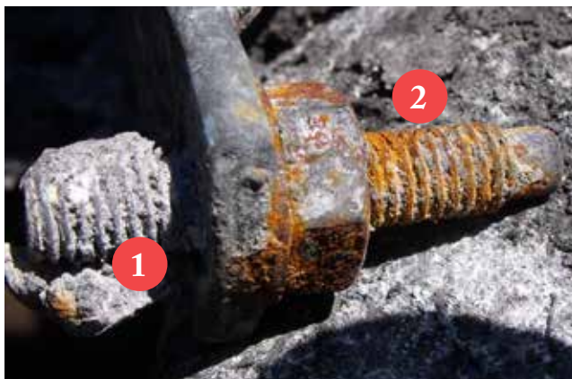
AZ ERŐS KORROZÍÓ ÉS FRÖCCSENÉS NYOMAI
