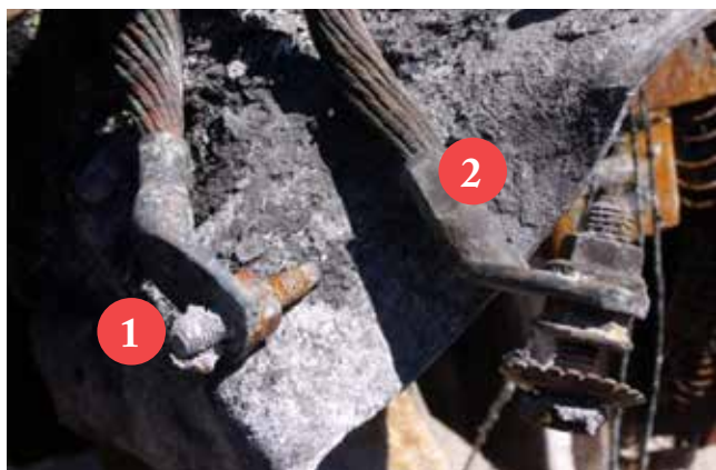
A GENERÁTORRA CSATLAKOZÓ SARUK
