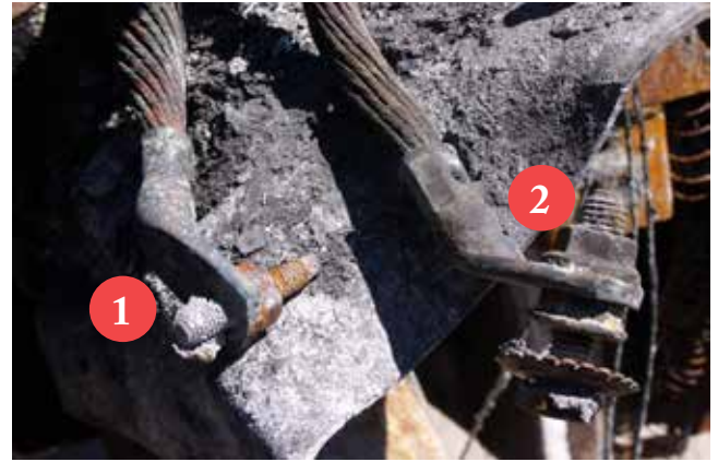
A GENERÁTORRA CSATLAKOZÓ SARUK MARADVÁNYA
