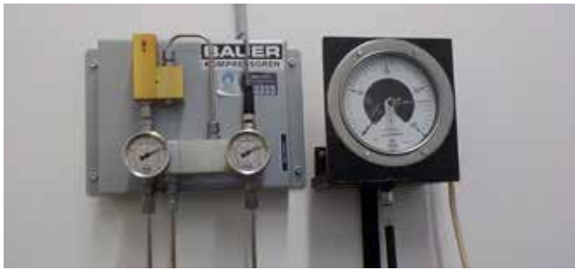
ÁTVÁLTÓ A PALACKKÖTEGEK ÉS A KOMPRESSZOR KÖZÖTT
