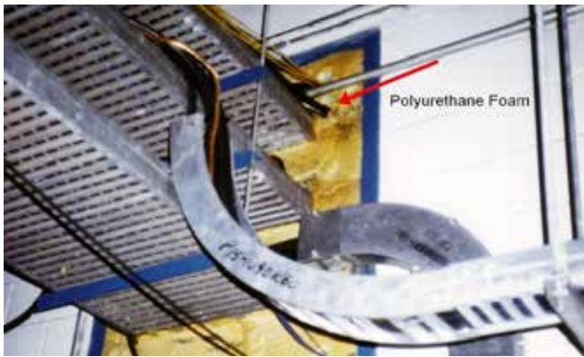
PUR HABBAL KITÖLTÖTT KÁBELÁTVEZETÉS AZ ATOMERŐMŰBEN
