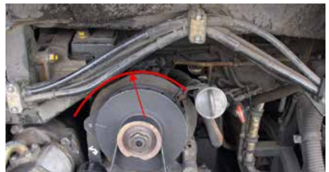
11. ÁBRA: SZÁLSZAKADÁS ESETÉN A SÚRLÓDÁS HELYE
