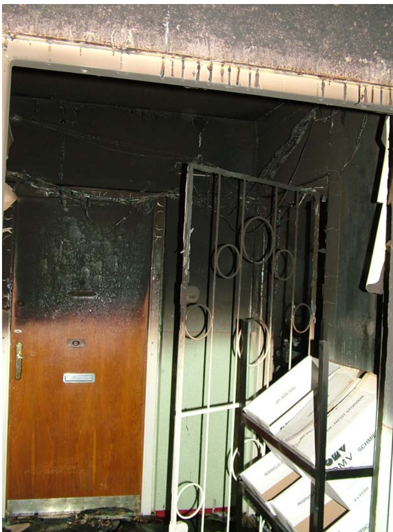
20. Első emeleti másfélszobás lakás, fémrácsos lezárása. A szomszédos lakásra áttérjedhetett volna a tűz.
