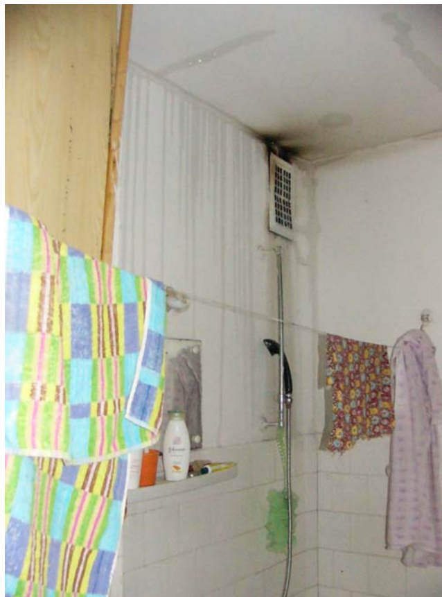
19. Földszint 2. –fürdőszoba, a konyhával határos falán, füstnyomok a szellőzőn.
