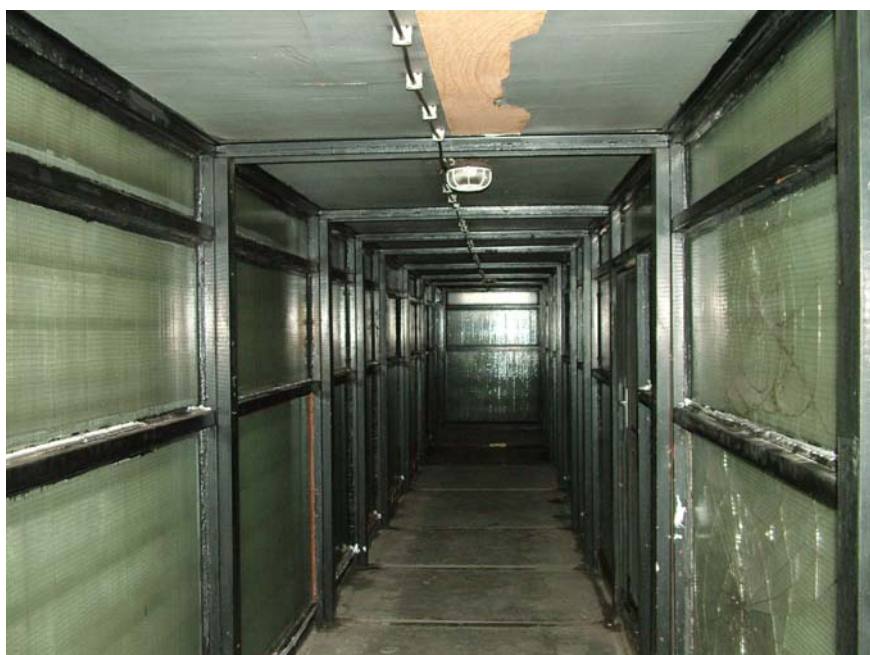
51. A zárt tetőtéri átjáró.
