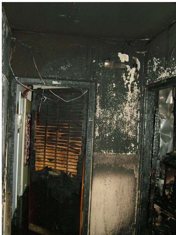
36. Hatodik emeleti lépcsőházi közlekedő. A tűz a jobb oldali lakásból terjedt át a szomszédos lakásra.
