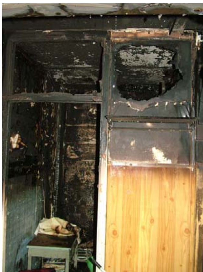
25. Második emeleten a konyharész házilag leválasztásra került, ajtaja zárva volt, ezért a tűz nem terjedt át a lakásra.
