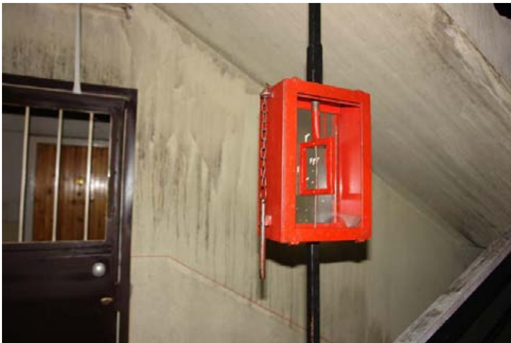
52. A füstelvezető szerkezet működtetője. Háttérben vasajtós lezárás a közlekedő folyosón.
