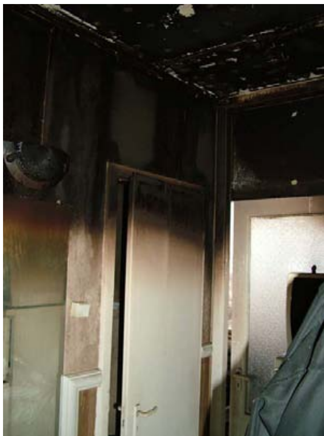
28. Harmadik emeleti belső ajtók zárva voltak. A tűz nem terjedt ki.
