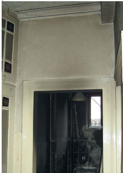
4. ábra: a lépcsőházban alig keletkezett füstkár (forrás: Brandschutz 5/2005.)
