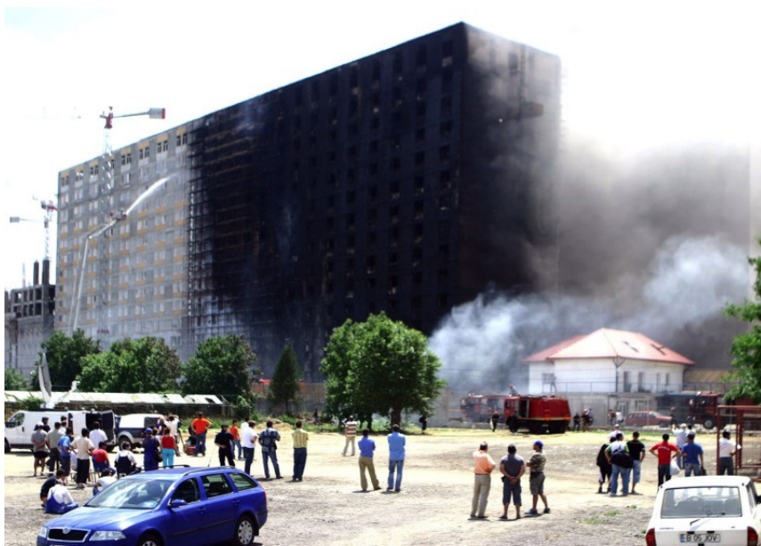
Az utólagosan szabálytalanul beépített loggiák között a legjobb esetben sincs meg az 1,3 méteres tűzvédelmi gát!
