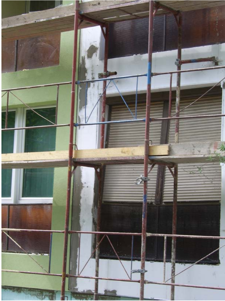
Az utólagosan szabálytalanul beépített loggiák között a legjobb esetben sincs meg az 1,3 méteres tűzvédelmi gát!
