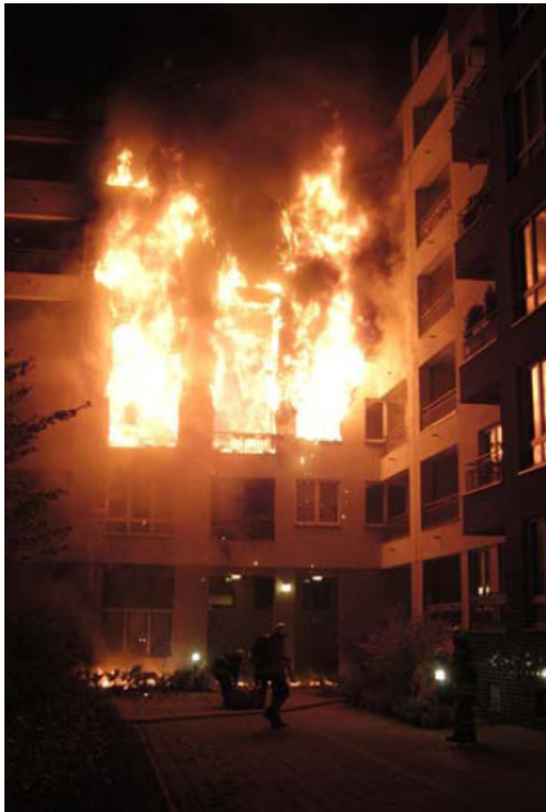
13. ábra Tűzátterjedés homlokzaton
