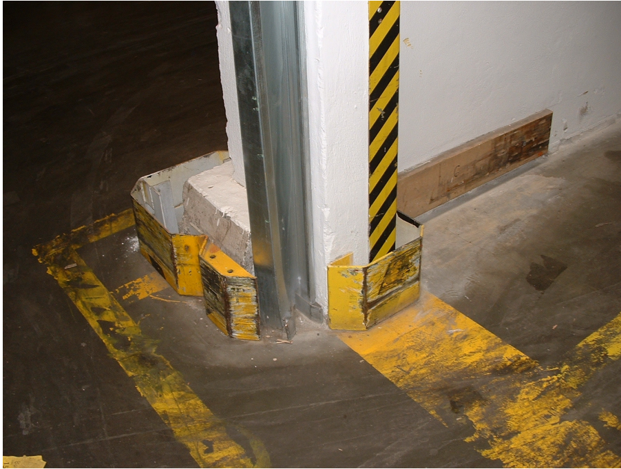
3 sz. kép. Tűzgátló tolókapu mechanikai védelmének hibája: a túl közel beépített védelem is sérült, nemcsak a kapu tokja – így nem csukódik megfelelően a kapu
