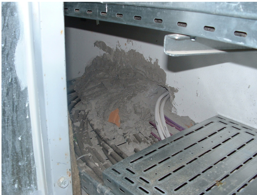
4 sz. kép. Tűzgátló tömítőhabarcs egy A kategóriás irodaházban. Nemcsak a szennyezés indokolatlan mértékű, de a gyakori átalakítások miatti helyreállítás is körülményes, vagy egyszerűen nem történik meg
