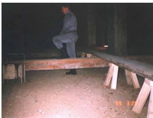
20.ábra Magas kötőgerenda a Lad-Gyöngyöspusztai Szociális Otthon padlasterében
