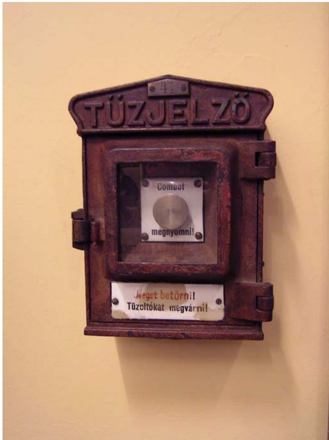
12. Kép: A Sprinkler-féle jelzőharangos utcai tűzjelző készülék
