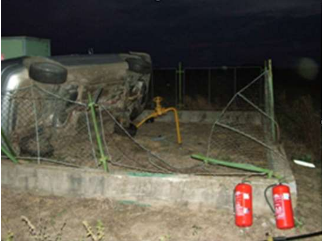
6. ábra Közlekedési baleset miatt megrongálódott fogadó állomás
