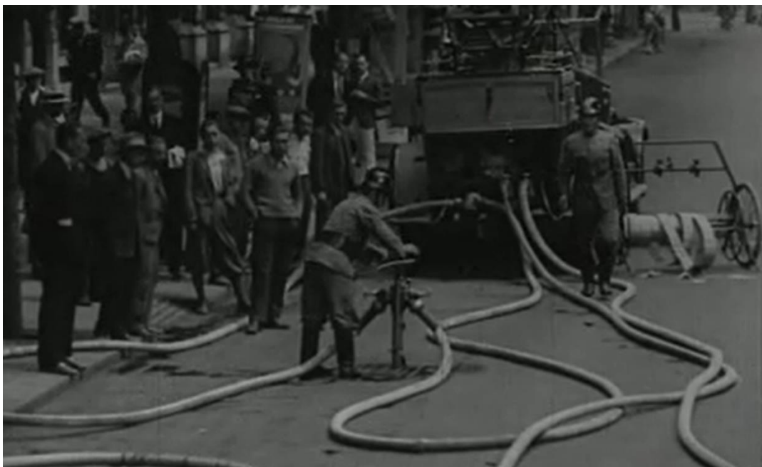
6. kép – 1932-ben, az Operaháznál megtartott próbariadón egy földalatti tűzcsapról megszerelt táplálás
