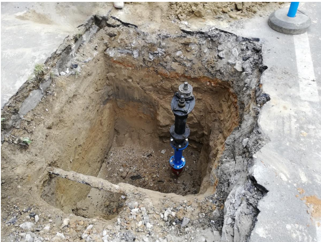
7. képsorozat – Új föld alatti tűzcsap elhelyezése meglévő parkoló alatt forrás: saját fotók; Bp VIII., József utca
