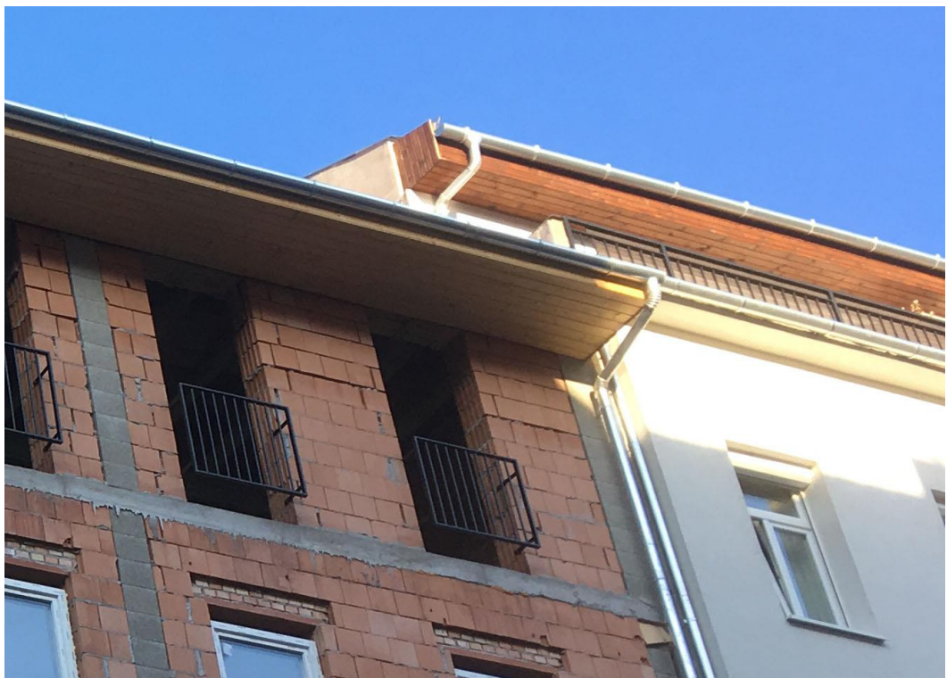
4.13. ábra – Szélsőségesen eltérő ereszkialakítások (saját gyűjtés)
