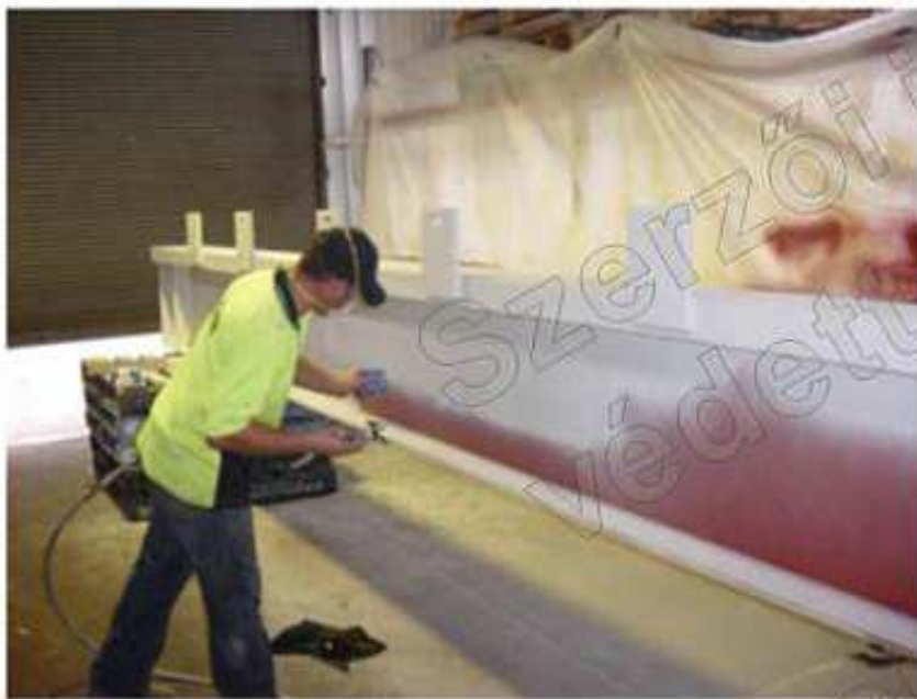
Nedves rétegvastagság üzemi mérése
