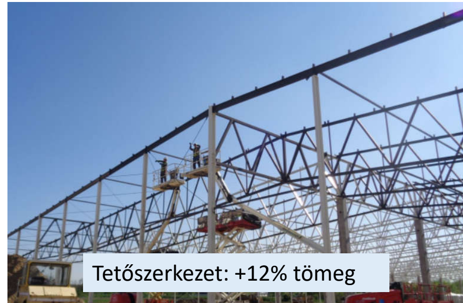
tetőszerkezet + merevítése: R15
