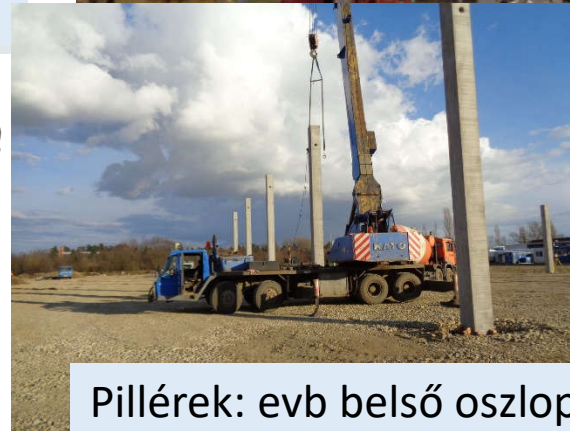
függőleges tartószerkezet (és merevítései): R30
