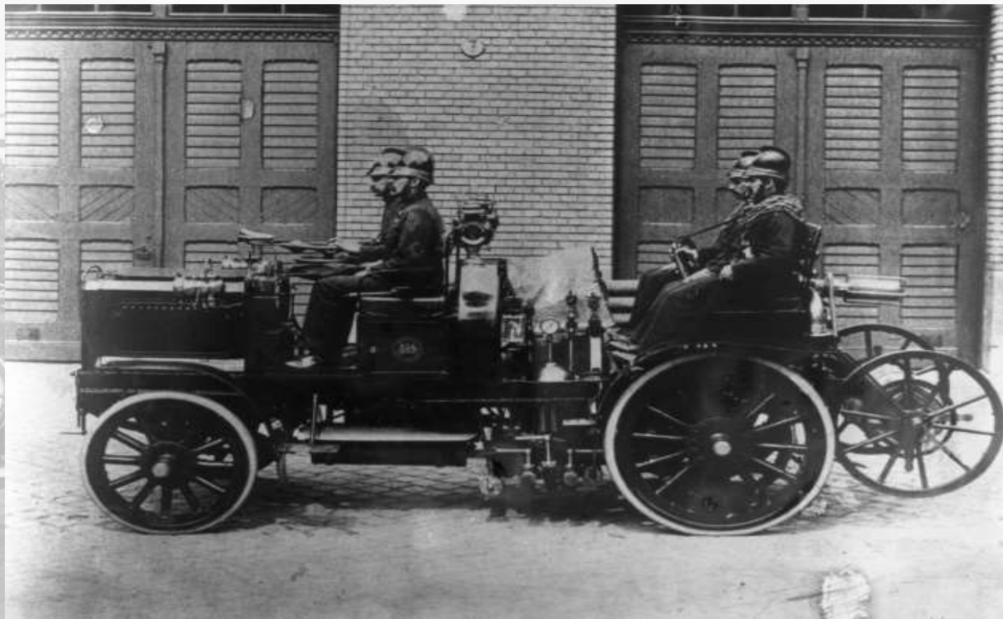
A Budapesti Önkéntes Tűzoltó Egyesület első benzinmotoros (magánjáró) gépjárműfecskendője
