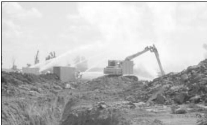
A kút környékét hűtő víz elvezetéséről is gondoskodni kellett
