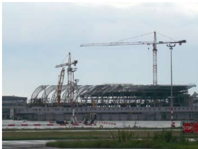
Jelentős megtakarítások érhetők el magasépítési beruházásoknál
