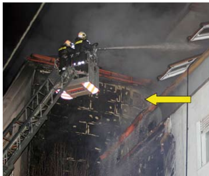
A szemetes kuka égésétől a homlokzat és a tetőszerkezet is megsemmisült
