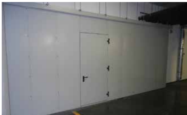
HŐSZIGETELT ACÉL TOLÓKAPU (EGYSZÁRNYÚ KIALAKÍTÁSBAN, ÁTJÁRÓ AJTÓSZERKEZETTEL. A SZÁRNY MOZGÁSA EGYENES VONALÚ, VÍZSZINTES, SZERKEZETE TÖBB, EGYMÁSHOZ FIXEN KAPCSOLÓDÓ PANELBŐL ÉPÜL FEL)
