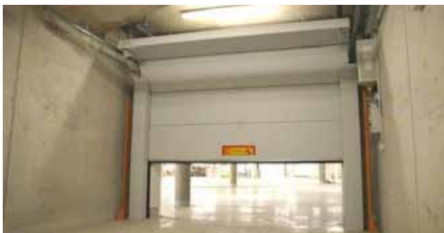
TŰZGÁTLÓ, EMELKEDŐ SZÁRNYÚ ELEMES KAPU, NYITOTT HELYZETBEN VÍZSZINTES HELYZETŰ SZÁRNYELEMEKKEL
