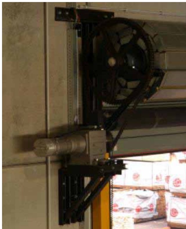
TŰZGÁTLÓ REDŐNYKAPU TARTÓSZERKEZETE
