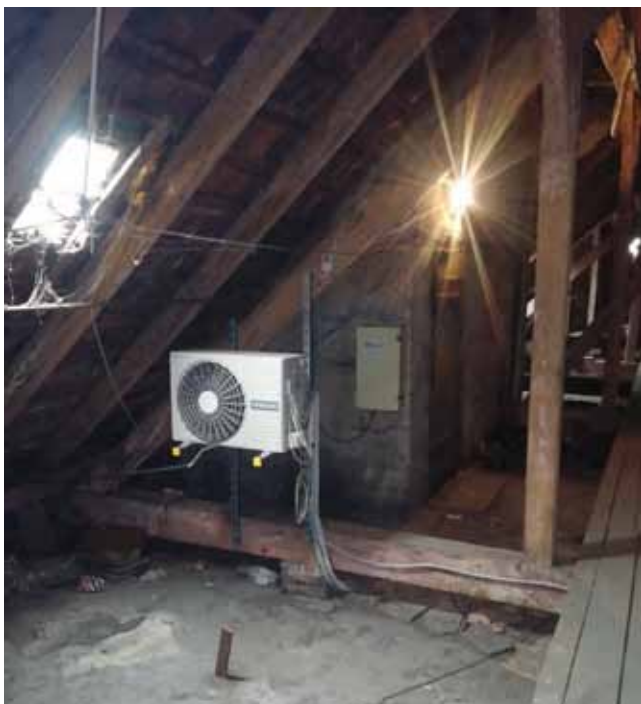
LÉGKONDITIONÁLÓ KÜLTÉRI EGYSÉG A PADLÁSON
