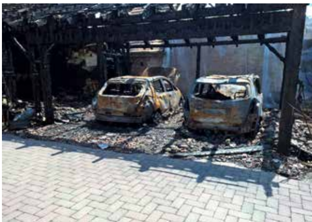
A GÉPKOCSIBA ÉPÍTETT TÖLTŐ INVERTEREGYSÉGÉBEN KELETKEZETT A TŰZ
