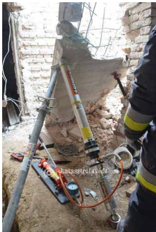
MEGDŐLT FAL MEGTÁMASZTÁSA
