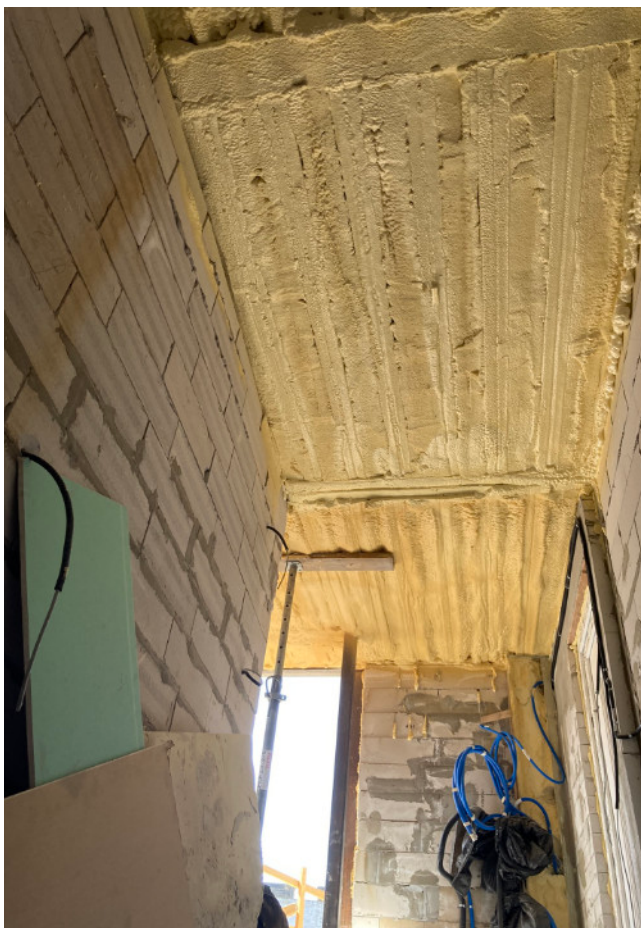
2. ÁBRA – SZÓRT PUR-HAB A FÜSTMENTES LÉPCSŐHÁZ MENNYEZETÉN
