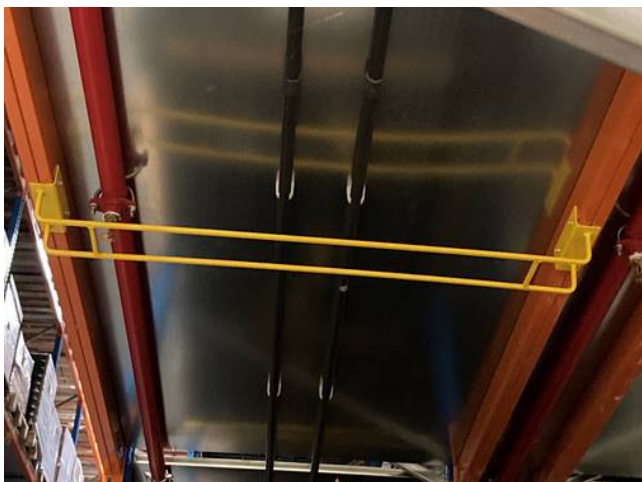
AZ ÚJ RAKTÁR ASPIRÁCIÓS FÜSTÉRZÉKELŐVEL ÉS SPRINKLERVÉDELEMMEL
