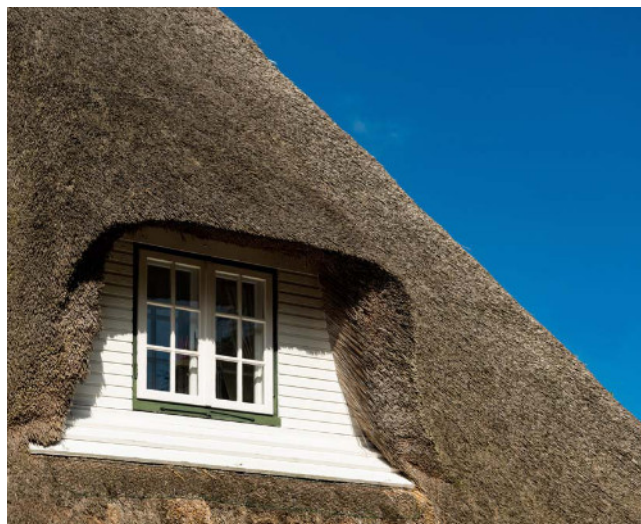
BEÉPÍTETT TETŐTÉR – MÁK KIHÍVÁS
