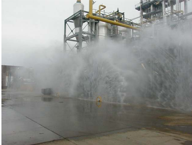
27. kép. Beépített vízfűgöny alkalmazása ipari környezetben
